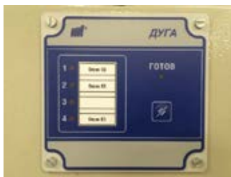
Рисунок 46 – Регистратор дуговых замыканий ДУГА-О
